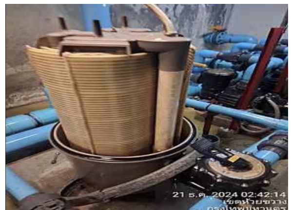
รูปที่ 37 เจ้าหน้าที่ทำความสะอาดเครื่องกรองน้ำสระว่ายน้ำ
