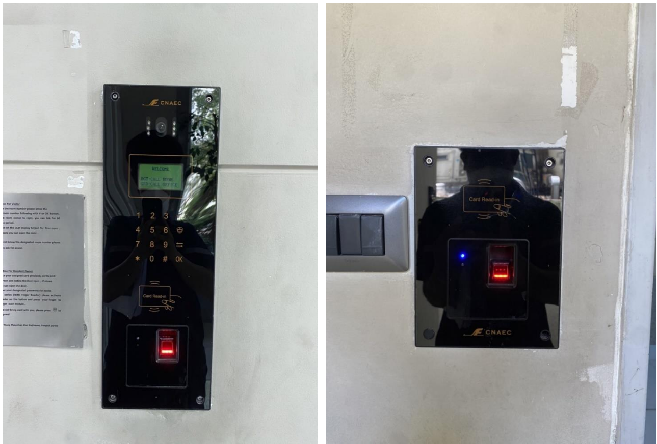
รูปที่ 43 ใช้ระบบแสกนนิ้วและบัตรเข้าภายในอาคาร
